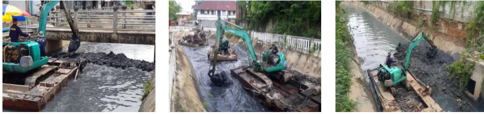
การดำเนินงานภายในคลอง ที่ต้องยกเครื่องจักรกลลอยน้ำ ไม่ใช่ตักบ่นฝังอย่างเดียว
