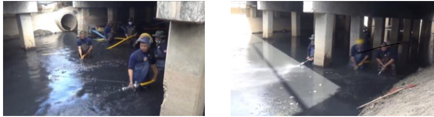
รูปใต้สะพาน ใช้เครื่องดันน้ำ
